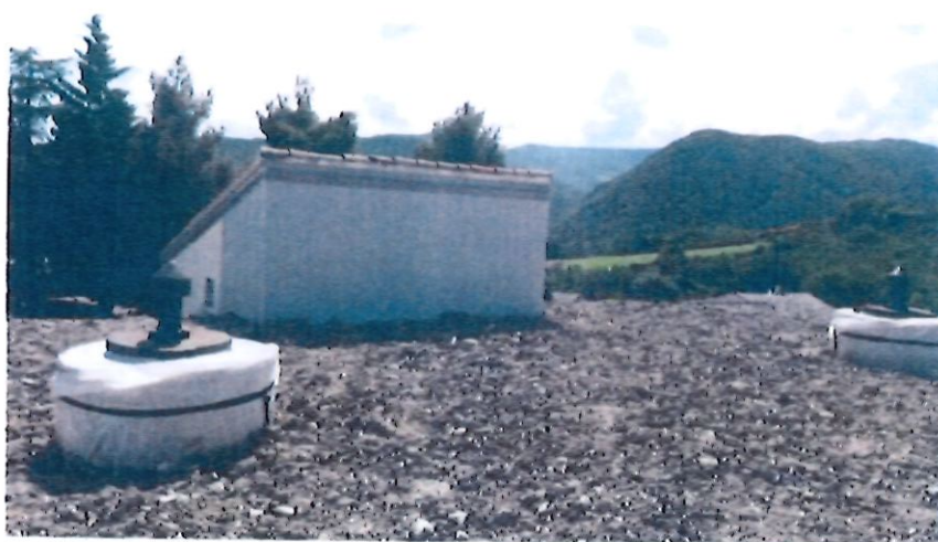
Etanchéité sur cuve et chambre de vannes réservoir de l'Aubre Meysse
