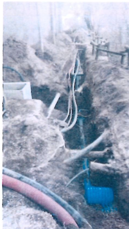
CRUAS STADE - renouvellement de réseaux
