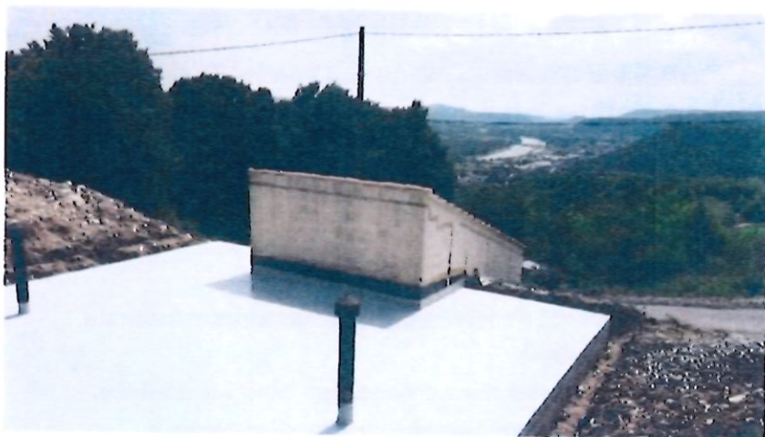
Etanchéité sur cuve réservoir la Blache Rochemaure
