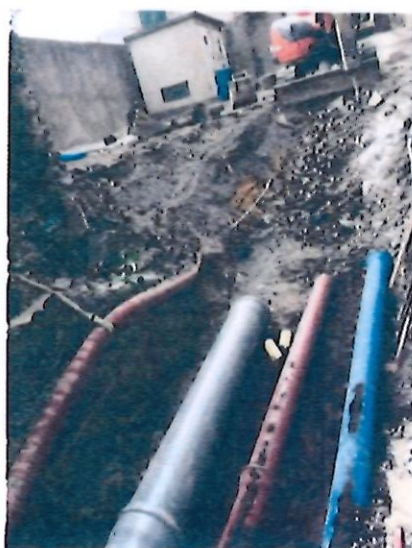
CHOMERAC – Renouvellement réseaux
