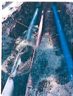
CHOMERAC – Renouvellement réseaux
