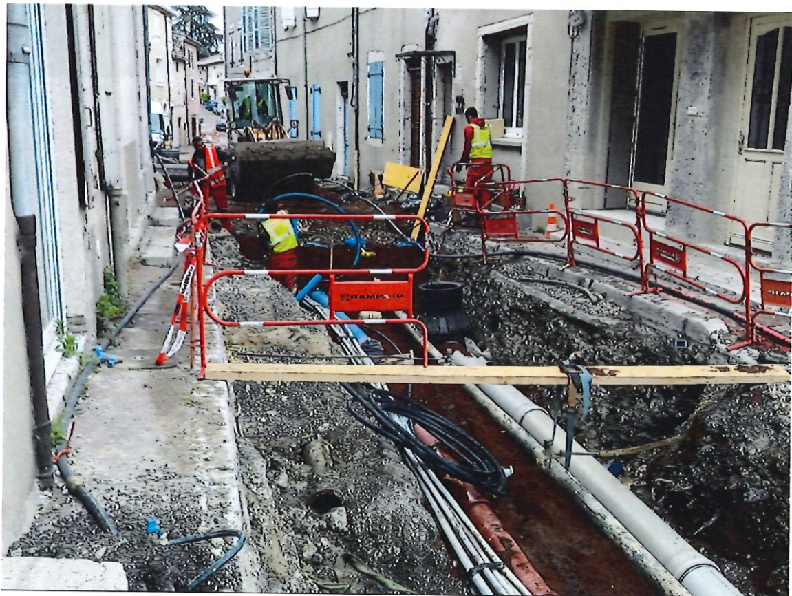
Chomerac, renouvellement des réseaux
