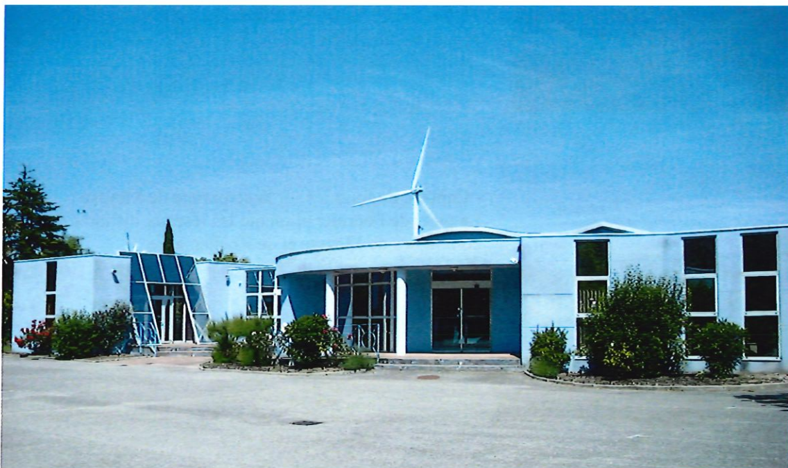
Bureau du Syndicat des Eaux Le Pouzin
